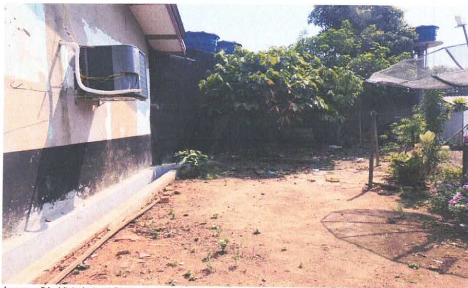
Imagem 04 - Vista Lateral Direita do Imóvel
