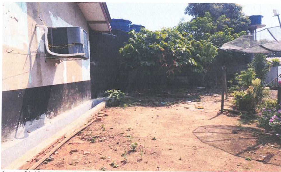
Imagem 04 - Vista Lateral Direita do Imóvel
